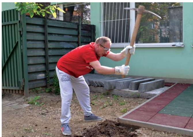
Pavel Grega začína odkopávať zeminu.
