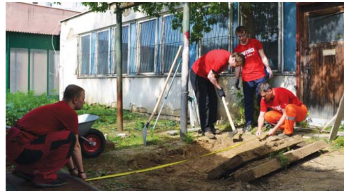
Príprava je dôležitá – otec a syn Hurovci s Eduardom Pištejom vytyčujú, kadiaľ treba vykopať ryhu na obrubníky. Pomáha im Lukáš Ťapajna.
