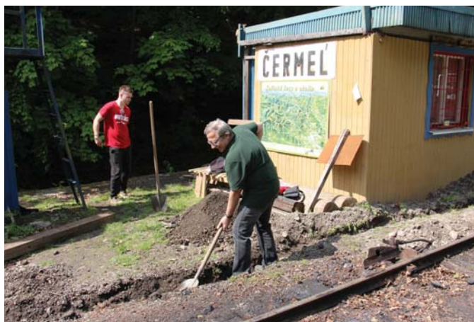
Do výkopových prác sa pustil Štefan Vojtko.
