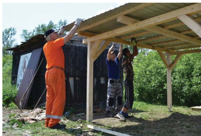
Ešte kúsok a prístrešok je dokončený.
