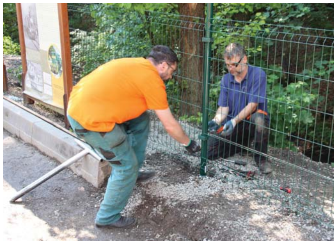
Pre bezpečnosť detí, ktoré sa budú hrať na novovybudovanom ihrisku, osadila partia z košickej detskej železnice nové oplotenie.
