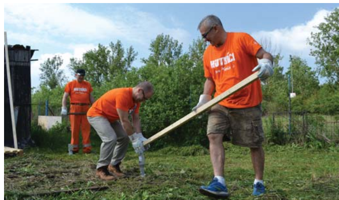
Takto sa zakrúca do zeme veľký vrut, na ktorom bude stáť každý stĺp prístrešku. Prezident USSK Scott Buckiso a viceprezident pre IT Richard Shank pôsobia ako dokonale zohratá dvojica.
