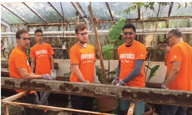
Pred začiatkom rekonštrukcie bolo treba vynieť zo skleníka všetku zeleň.
